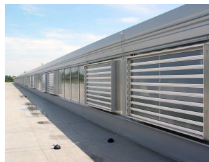
▲ FCO zsaluk polikarbonát lamellákkal
