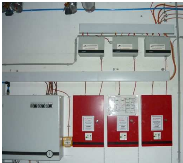
▲ Colt pneumatikus vezérlő rendszer vészkezzelakkal
