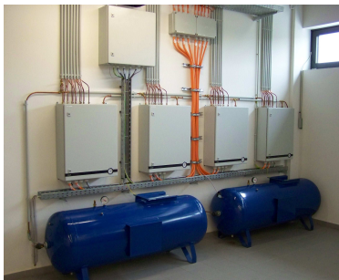
▲ Colt pneumatikus vezérlő rendszer légtartályokkal
