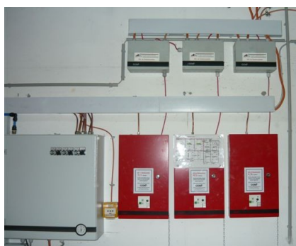
▲ Colt vezérlés - szellőztető központ és vészkazetták
