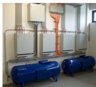
▲ Colt vezérlés - szellőztető központ és légtartályok
