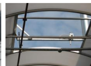
▲ RWA nyílászárny — belső nézet ▲
