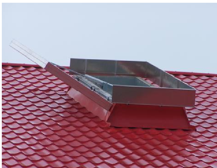
▲ Gravitációs hő-, és füstelvezető egyszárnyú berendezés
