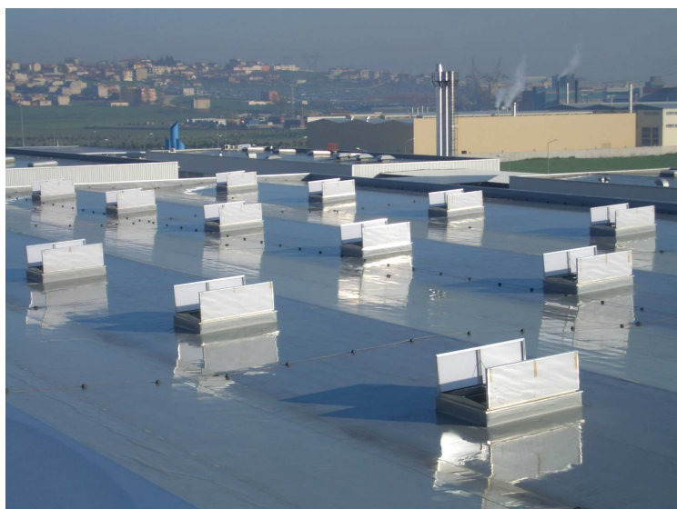
▲ Gravitációs hő- és füstelvezető, napi szellőztető kétszárnyú berendezések
