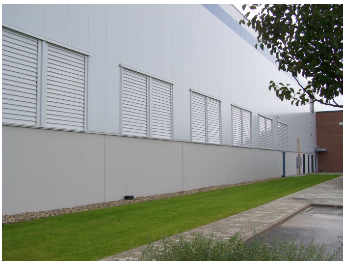
▲ Colt FCO homlokzati frisslevegő bepótló zsaluk festett alumínium lamellákkal
