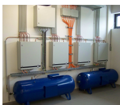
Colt szellőztető központos rendszer + légtartályok
