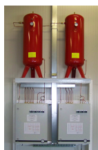
Colt szellőztető központos rendszer + légtartályok
