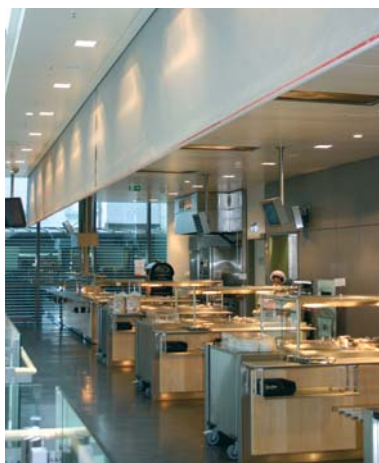
Gallileo-toronyház, Frankfurt (D) 220 méter füstkötényfal-rendszer került beépítésre a többszintes átriumrészen
